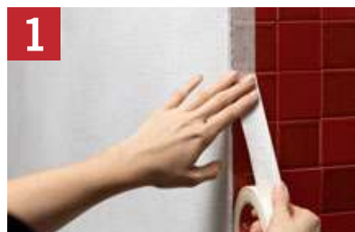
1 Boden und Keramik vor Beginn der Arbeiten unbedingt abdecken.
