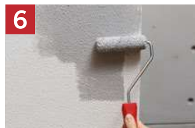
6 Anstrich gleichmäßig auftragen. Gegebenenfalls Fläche nach dem ersten Auftrag kurz antrocknen lassen (keinesfalls austrocknen lassen) und nochmals streichen.
