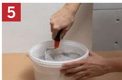
5 Angerührte Masse 10–15 Minuten stehen lassen und erneut durchrühren. Die fertige Anstrichmasse soll eine zähflüssige Konsistenz haben.
